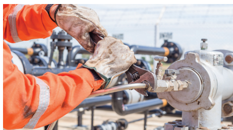
Tijdens onderhoudswerkzaamheden ter plaatse aan pompen, kleppen, en generatoren
