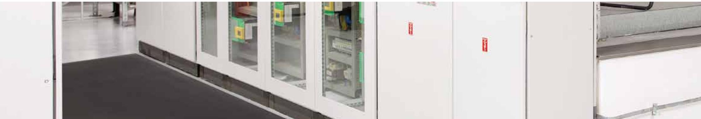
Isoliermatten verhindern, dass Arbeiter "geerdet" werden, und bieten Sicherheit bei Stromschlag.
